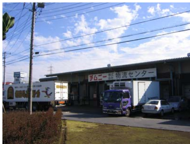
写真：川口第1物流センター
